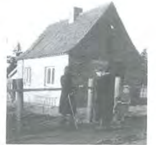
Spritzenhaus von 1939 ab 1948 Wohnhaus
