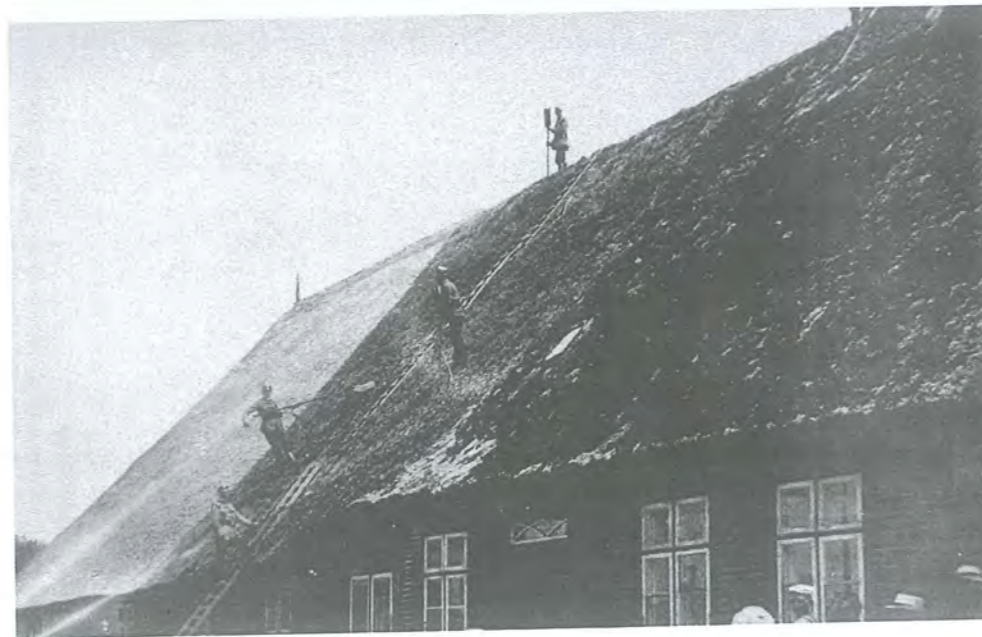
Steigertrupp mit Ansatzleiter, Dachleiter, Haltehaken und Patschen
